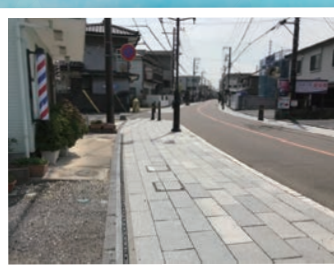
中山道の水たまり解消工事
